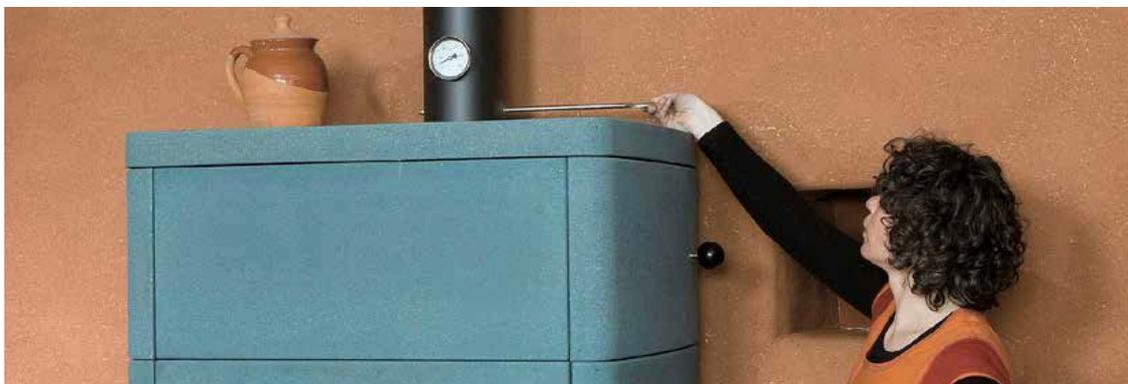
Pour ma sécurité et conformément aux réglementations en vigueur, la clef n'est pas totalement étanche.
